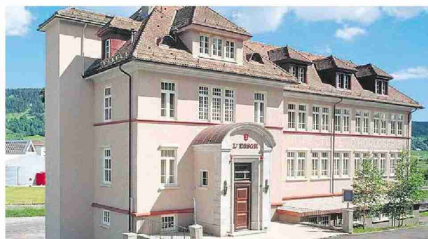
La rénovation de l'Espace horloger coûte 1,3 million de francs. -DR
